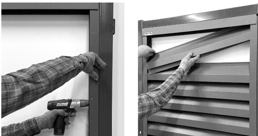
Заведите верхний край Стойки 60\*40 в Крышку 65\*60 и закрепите к боковой грани каркаса саморезами 5.5\*19 с шагом 45 см – 4 самореза на стойку. На противоположной грани по аналогии закрепите вторую стойку.
