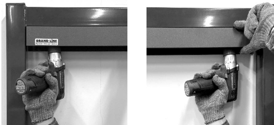
Закрепите Крышку на верхней грани каркаса двумя саморезами 5.5\*19. Следите, чтобы внешняя стенка крышки совпадала с плоскостью каркаса калитки.
